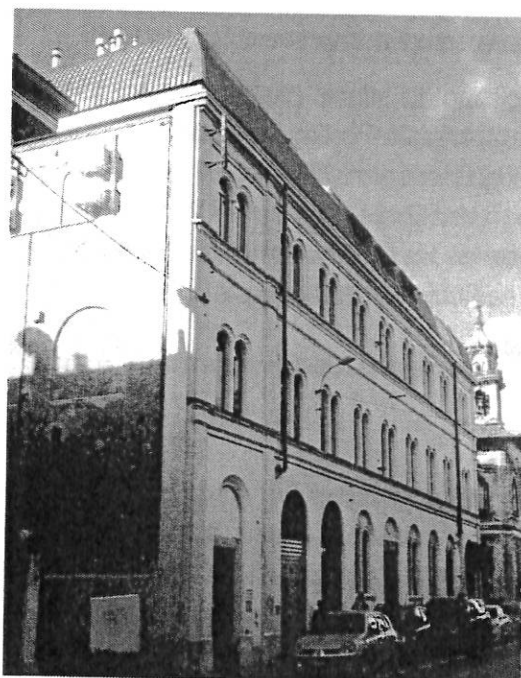
Prospetto generale, fronte via Como 10
