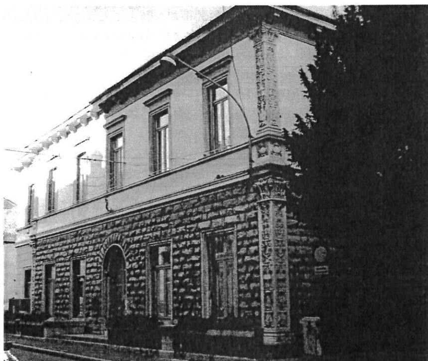
Prospetto generale, fronte via Como 13
