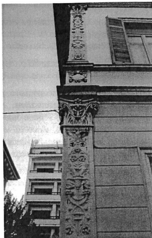
Particolari della facciata esterna
