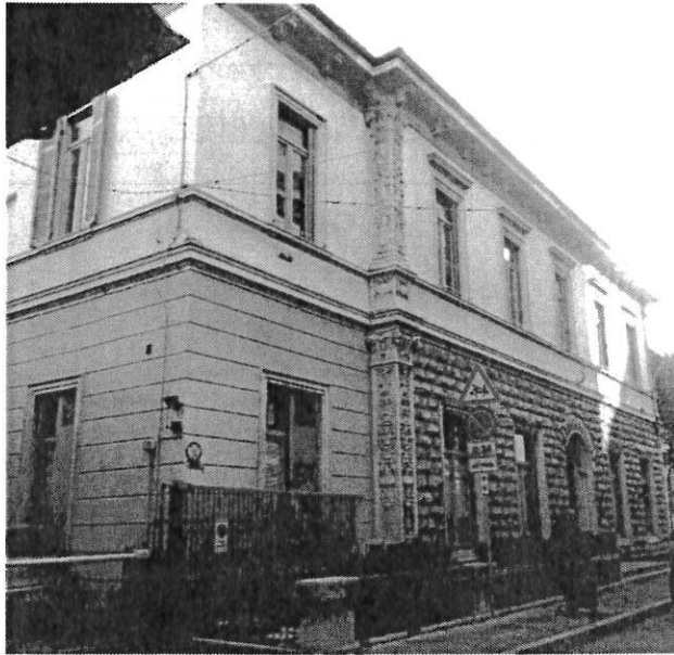
Fronte principale su Via Como
